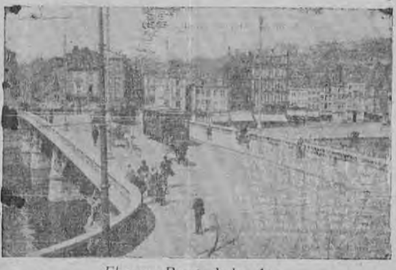
El nuevo Puente de los Arcos
